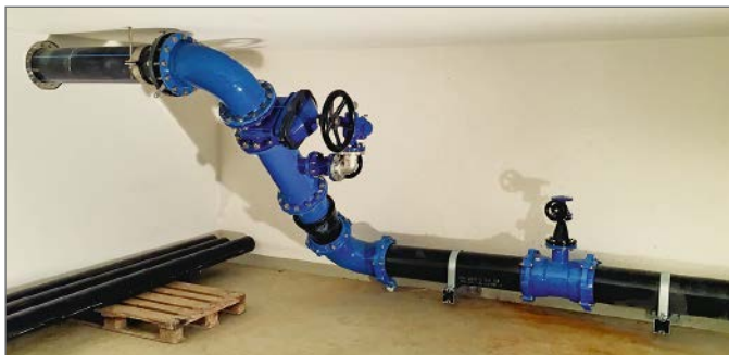
Anschluss der Löschwasserleitung im Portal „Engi“ mit Streckenschieber, Reinigungsvorrichtung und Entlüftungsventil.
