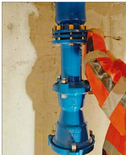
Montage eines Hydranten-Unterteils VARIO 2.0 auf die Steigleitung in der Hydrantenkammer
