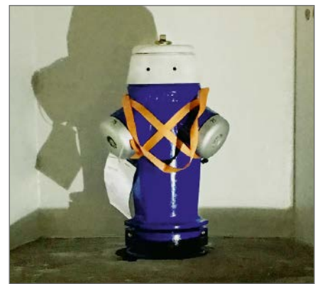
Hydrantennische mit montiertem Hydranten-Oberteil HYPLUS.
