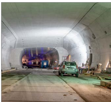
Fertiggestellte Ausstellbucht in der Tunnelmitte. Quelle: Bundesamt für Straßen (ASTRA), Schweiz
